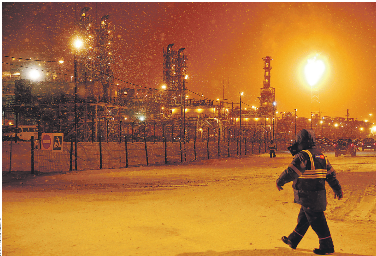
У НОВАТЭКа уже есть СПГ-проект за Полярным кругом — в декабре была запущена первая очередь завода «Ямал СПГ» (на фото) мощностью 5,5 млн т в год
