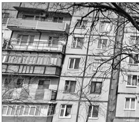
Квартиры пятиэтажки затопило дождевой водой.
