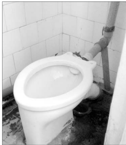
Водопроводная система закреплена деревянным брусом.
