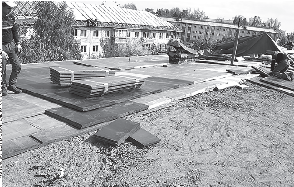
При монтаже кровли «ошиблись» с утеплителем.
