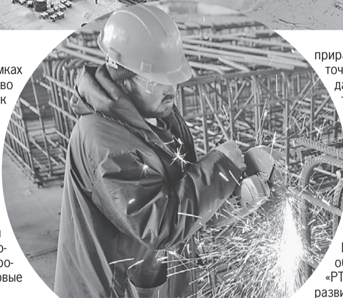
Монтаж оборудования на высокотехнологичном предприятии - дело тонкое.
