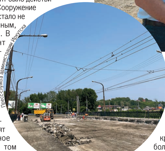
Работы ведутся круглосуточно.
