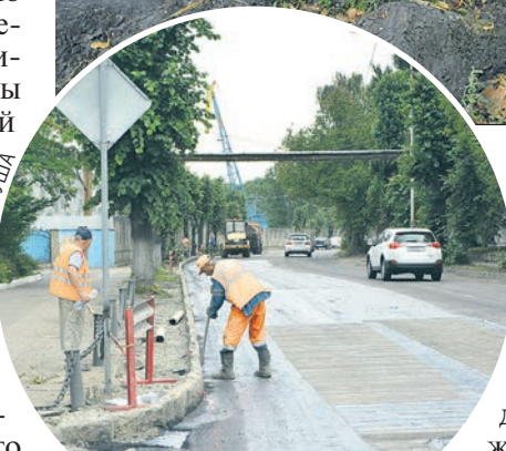
На Портовой уже укладывают верхний слой асфальтобетонного покрытия и меняют бордюры.
