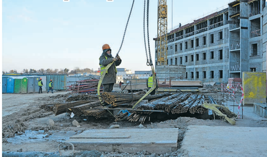
Сегодня на площадке работают около 160 человек.
