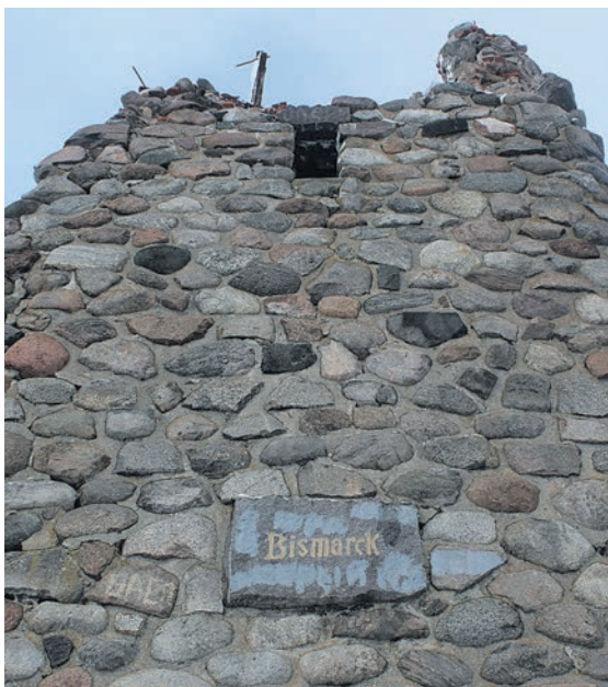
Два года назад у башни обрушилась верхняя часть. А ранее обвалилась винтовая лестница.
