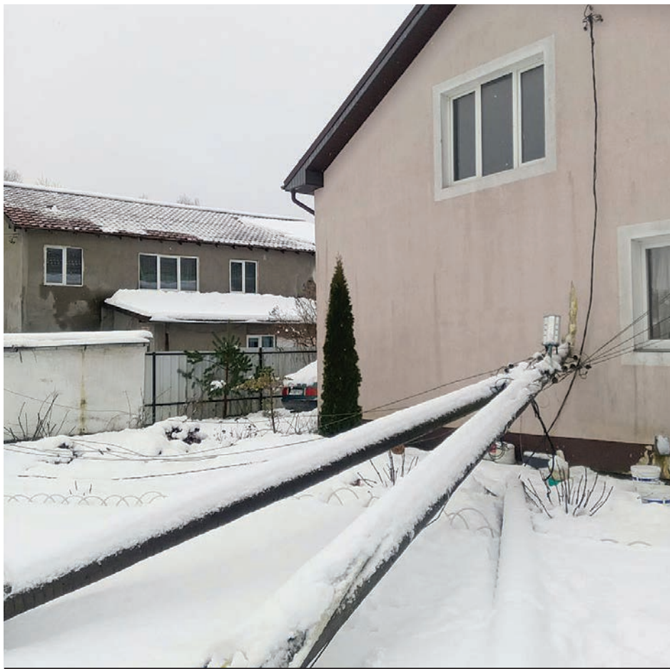
Холмогоровка. Деревянный столб под натиском мокрого снега и обледенения рухнул на жилой дом.
