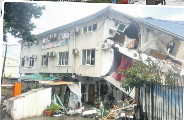
Вода и ветер подмыли и разрушили элинг в Сочи.
