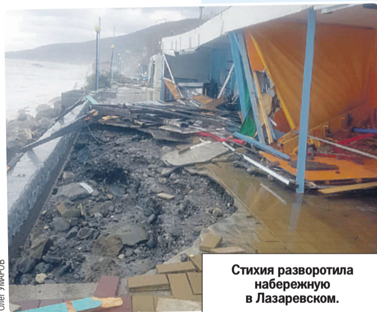
Вода и ветер подмыли и разрушили элинг в Сочи.
