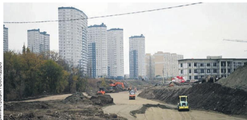
На данный момент ведется разработка земляного полотна и устройство насыпи из песка.
