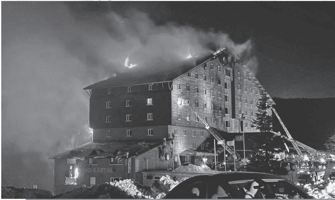
Облицованный деревом горный отель вспыхнул факелом. Сигнализация не сработала, автоматической системы пожаротушения в гостинице вообще не оказалось. Лестницы спасателей не доставали до верхних этажей, где люди оказались в огненной ловушке.
