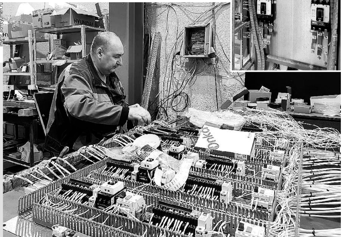
В электромонтажном цехе собирают начинку для подстанций.
