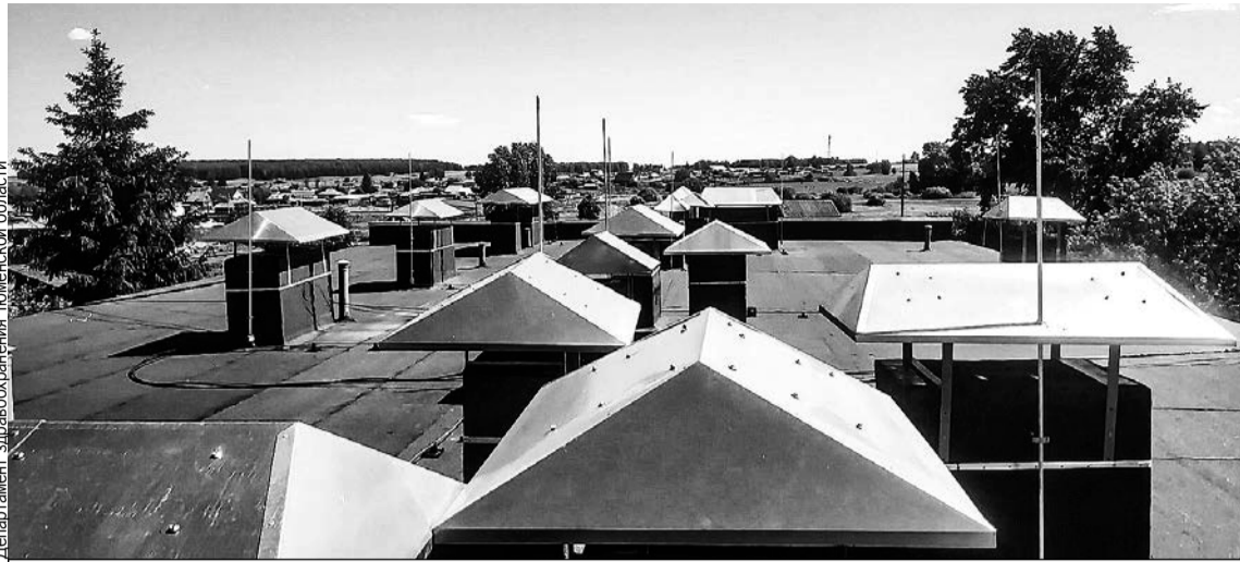
В здании поликлиники пятковской врачебной амбулатории обновили кровлю.
