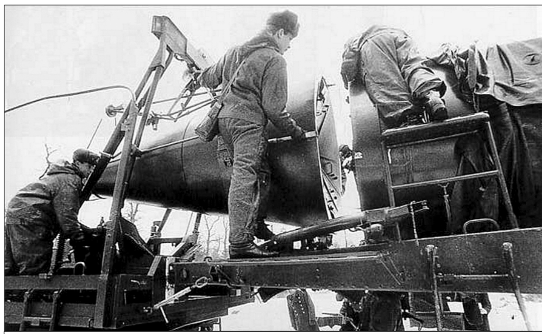
● Установка лёгкой боевой части на ракету Р-12.
