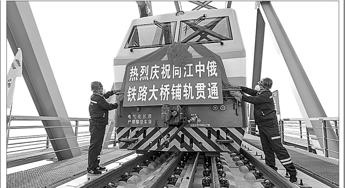
17 августа была осуществлена укладка рельсов на железнодорожном мосту Тунцзян — Нижнеленинское через реку Хэйлунцзян. Фото: ЮАНЬ ЮН («Жэньминьван»).
