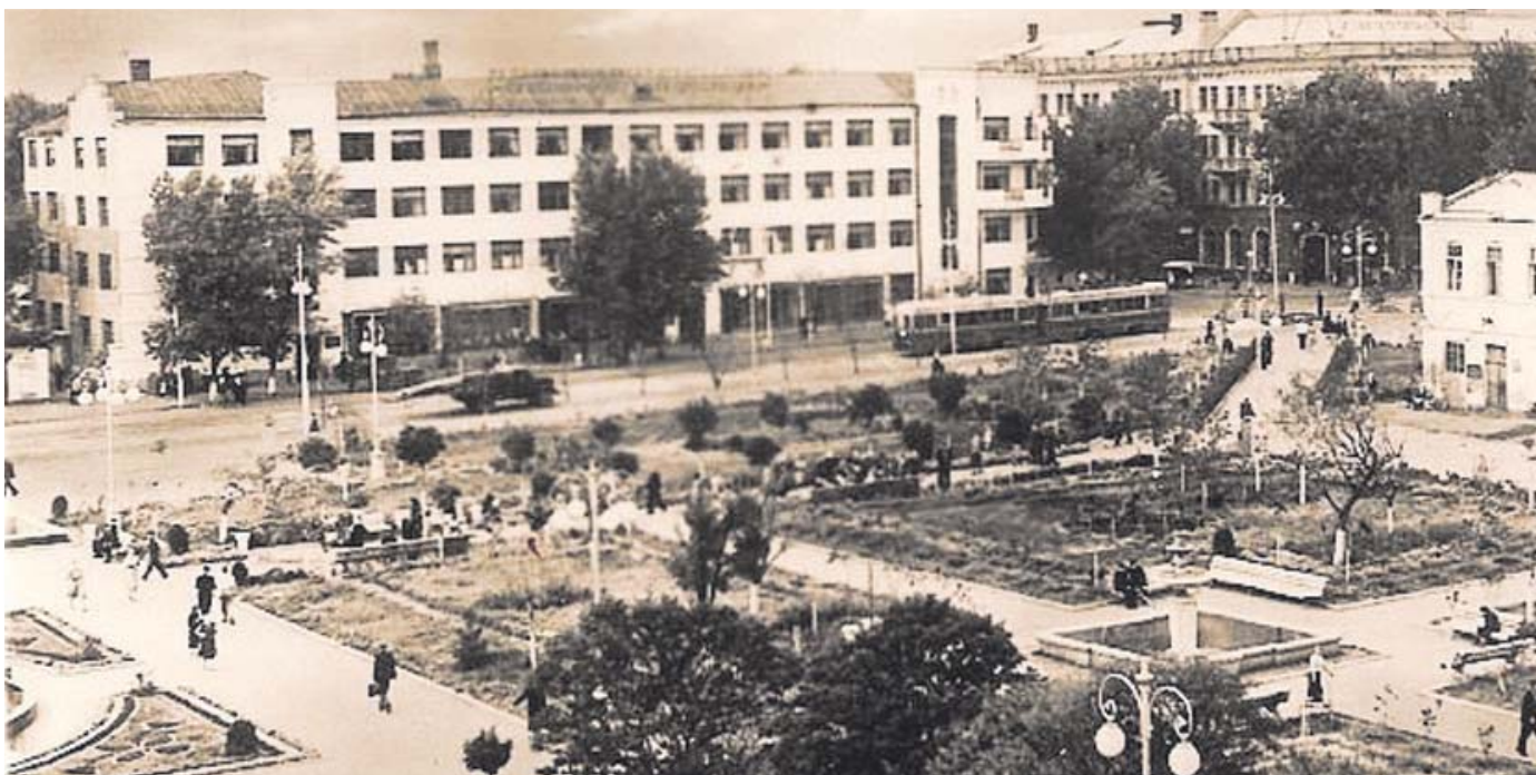
Площадь Ленина после реконструкции. Фото 60-х годов.
