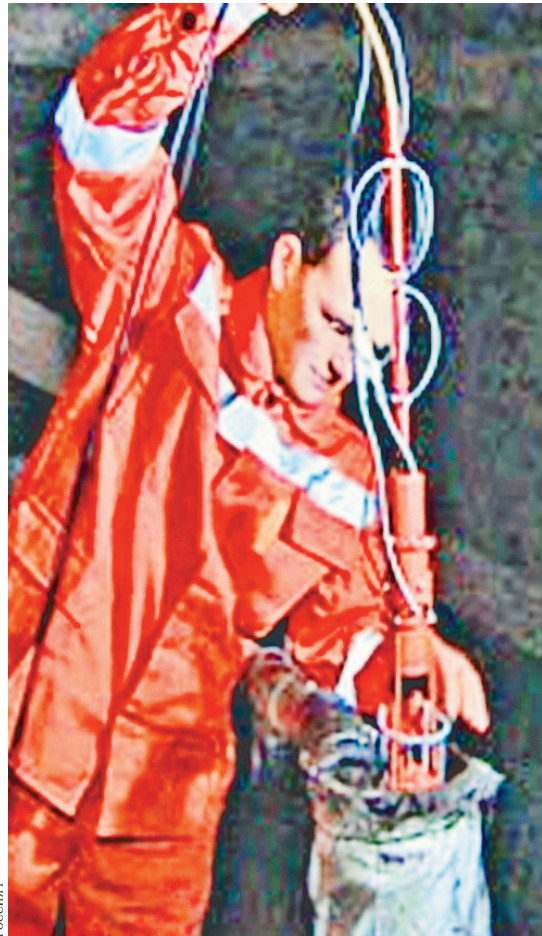
Появились устройства, позволяющие отрезать канализацию от конкретной квартиры, не перекрывая весь подъездный стояк.
