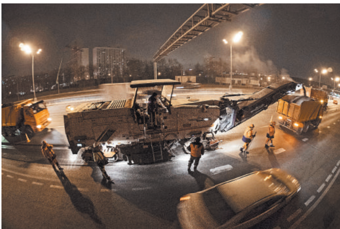
Чтобы не создавать пробки, МКАД ремонтируют ночью.
