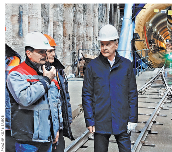
Чтобы запустить щит, Сергей Собянин (в центре) спустился на 44 метра в котлован станции «Мневники».
