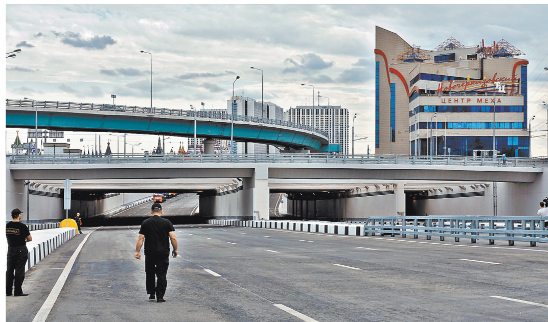
Строительство Северо-Восточной хорды в Москве завершено на 70%. По участку от «Ярославки» до Открытого шоссе идет разработка документации, а отрезок от Дмитровского до Ярославского шоссе начнут строить уже в 2019 году.
