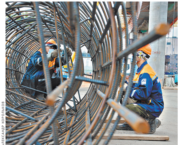
Строительство Северо-Восточной хорды вступает в решающую стадию.
