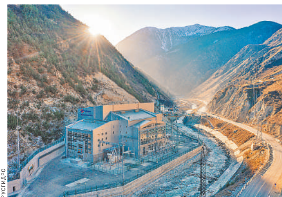
В здании Зарамагской ГЭС находятся два гидроагрегата, каждый мощностью 173 МВт.
