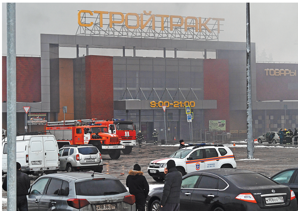
Парадный вход огонь пощадил — все разрушения пришлось на заднюю часть ТЦ
