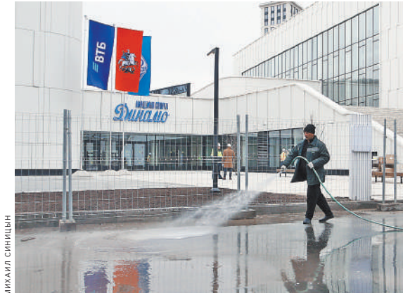
Строители наводят последний лоск перед открытием спорткомплекса.
