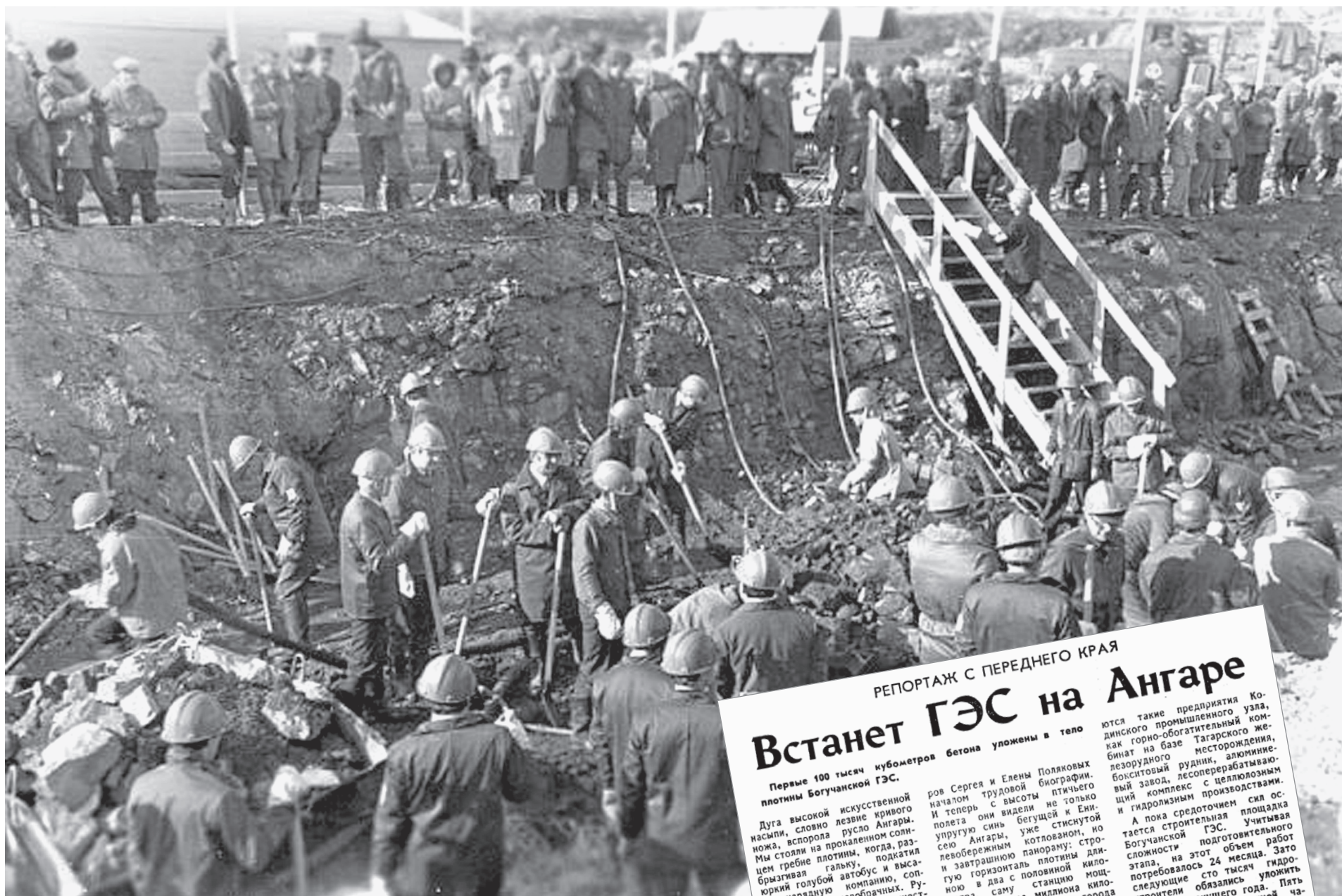
Богучанская ГЭС. Укладка первого кубометра бетона. 17 апреля 1982 года.
