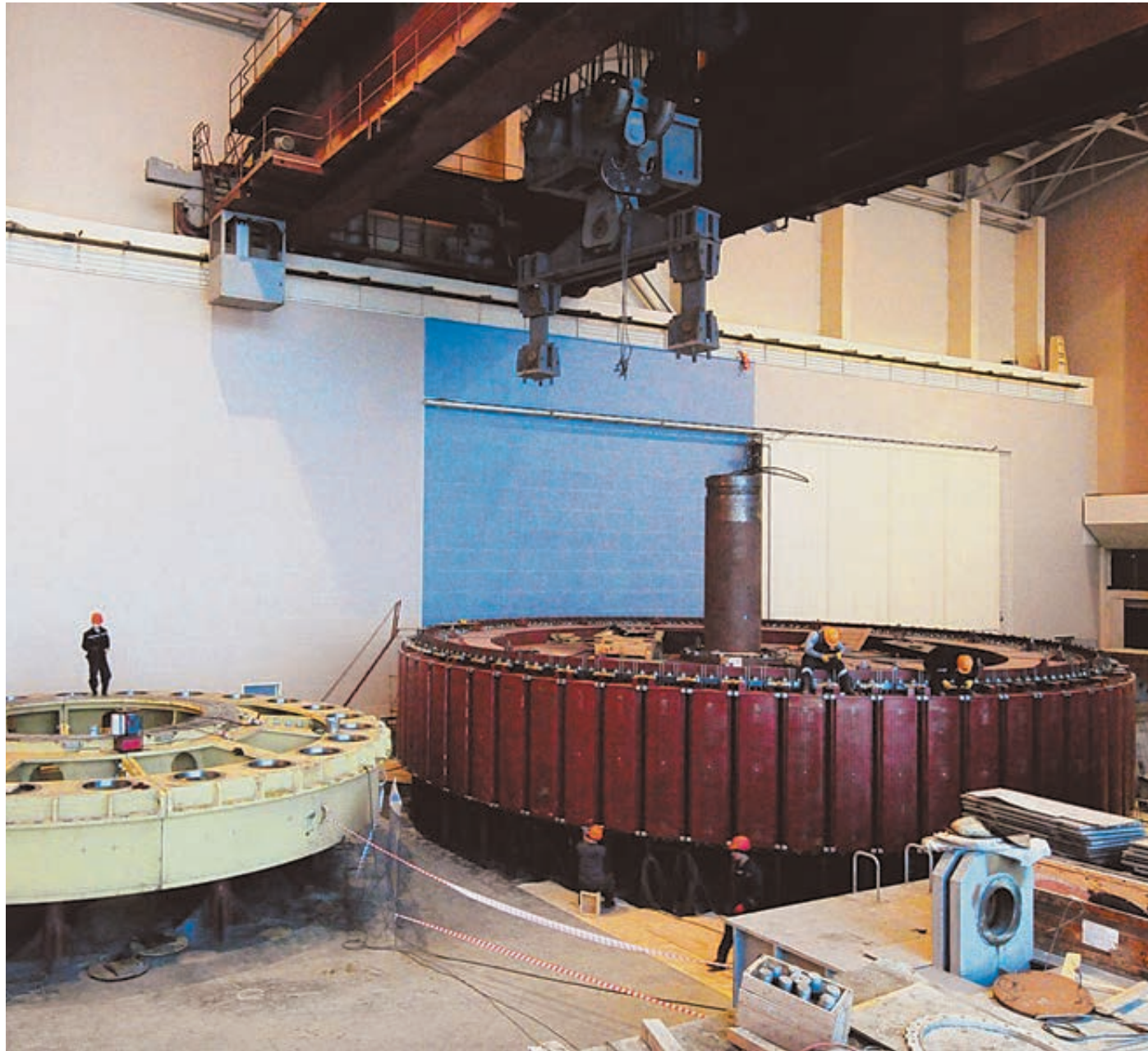
Идет сборка очередного гидроагрегата.
