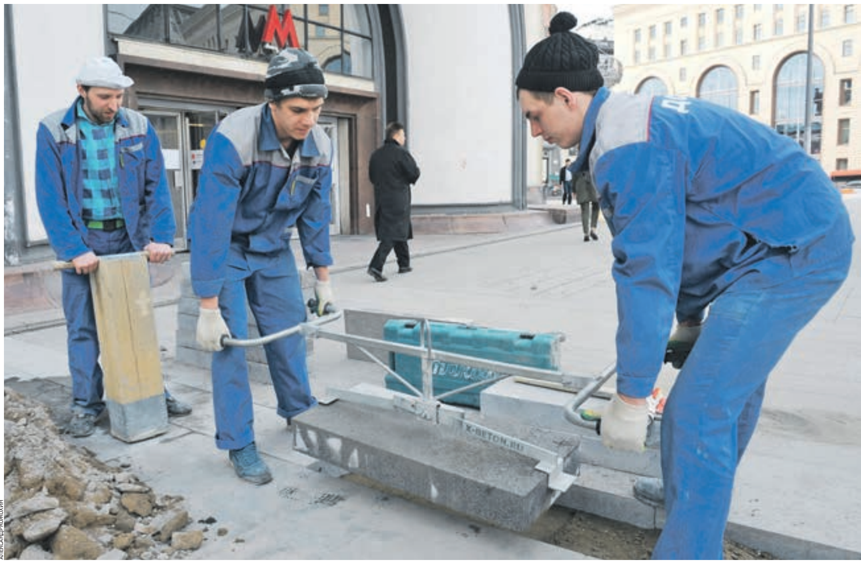
Вчера в 15:30 Слева направо: рабочие Андрей Иванов, Максим Мутин и Дмитрий Марнин укладывают плитку у станции метро «Лубянка». Работы по благоустройству пешеходной зоны ведутся от станции метро «Лубянка» до станции метро «Китай-город»
