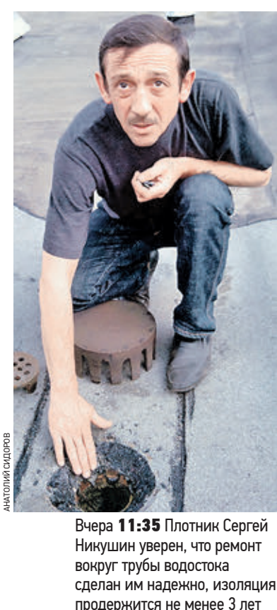
Вчера 11:35 Плотник Сергей Никушин уверен, что ремонт вокруг трубы водостока сделан им надежно, изоляция продержится не менее 3 лет
