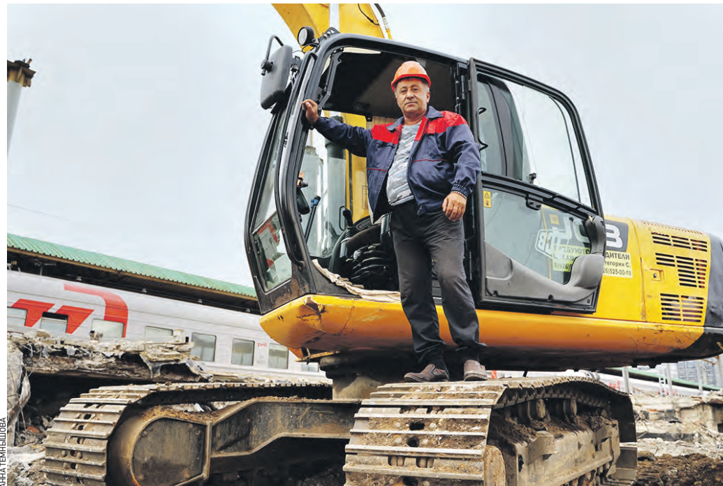
Вчера 10:28 Машинист экскаватора Мурат Голаев закончил демонтаж пятой платформы на Курском вокзале. Там построят новый транспортно-пересадочный узел
