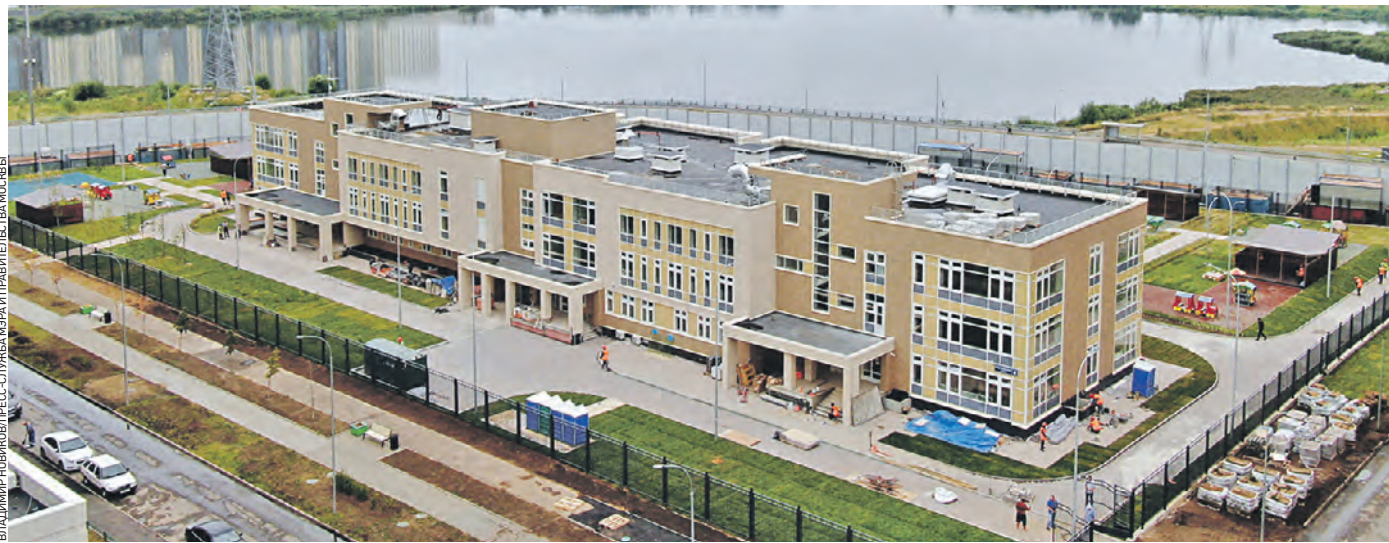
8 августа 2022 года. Готовый и открытию детский сад в столичном районе Некрасовка по адресу: ул. Лавриненко, дом 9
