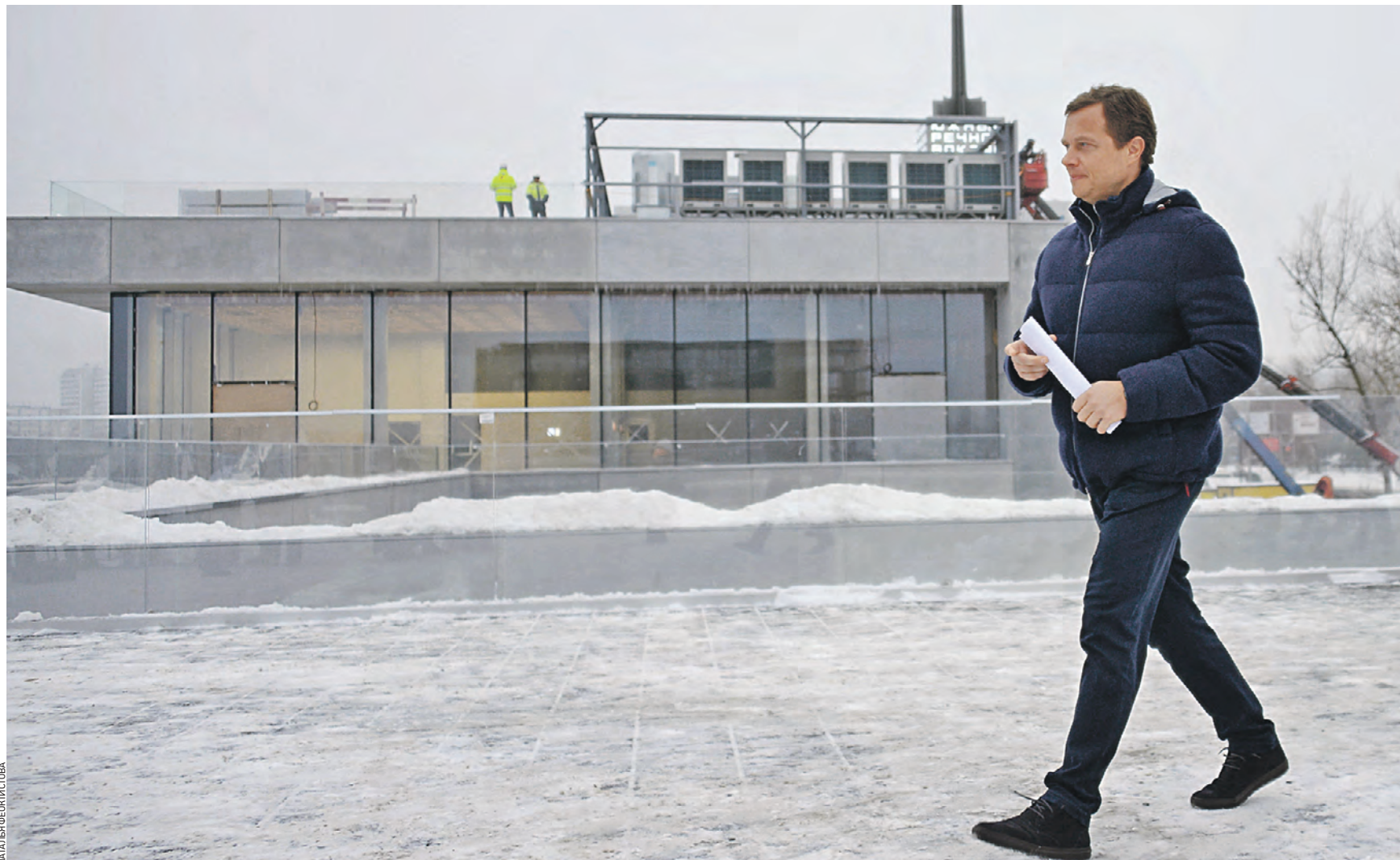
10 декабря 13:15 Заместитель мэра Москвы по вопросам транспорта Максим Ликсутов посмотрел, как ведется реконструкция Южного речного вокзала, и рассказал, каким будет этот объект после завершения всех работ
