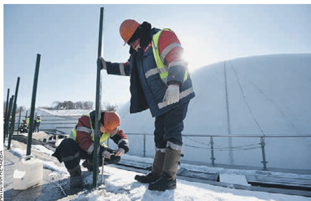
24 марта 2021 года. Сотрудники Гормоста демонтируют защитный купол фонтана в музее-заповеднике «Царицыно»
