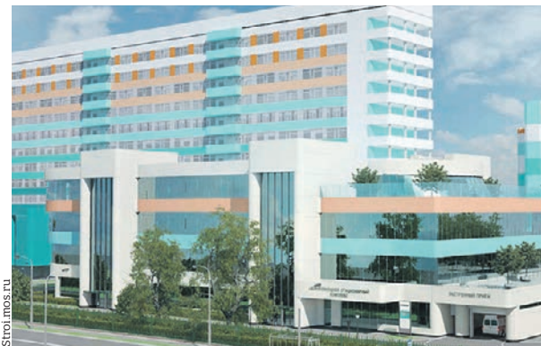
Проект здания скорпомощного комплекса ГКБ имени Филатова. Сейчас идут работы по его строительству
