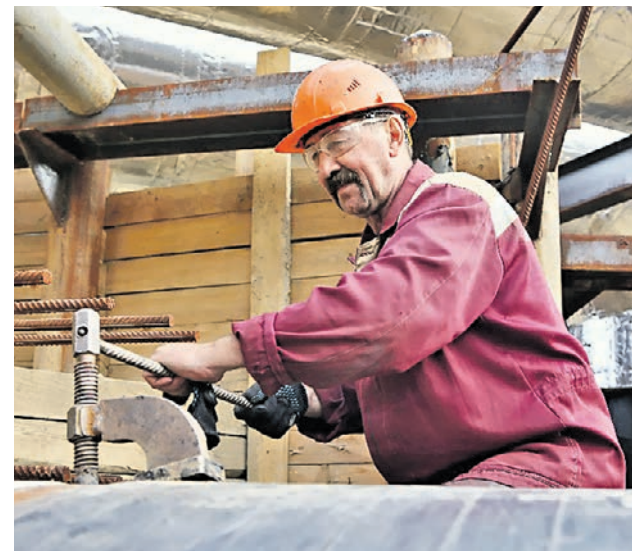
Монтажник Дмитрий Техников на строительстве пересадки между старой и новой «Авиамоторными»
