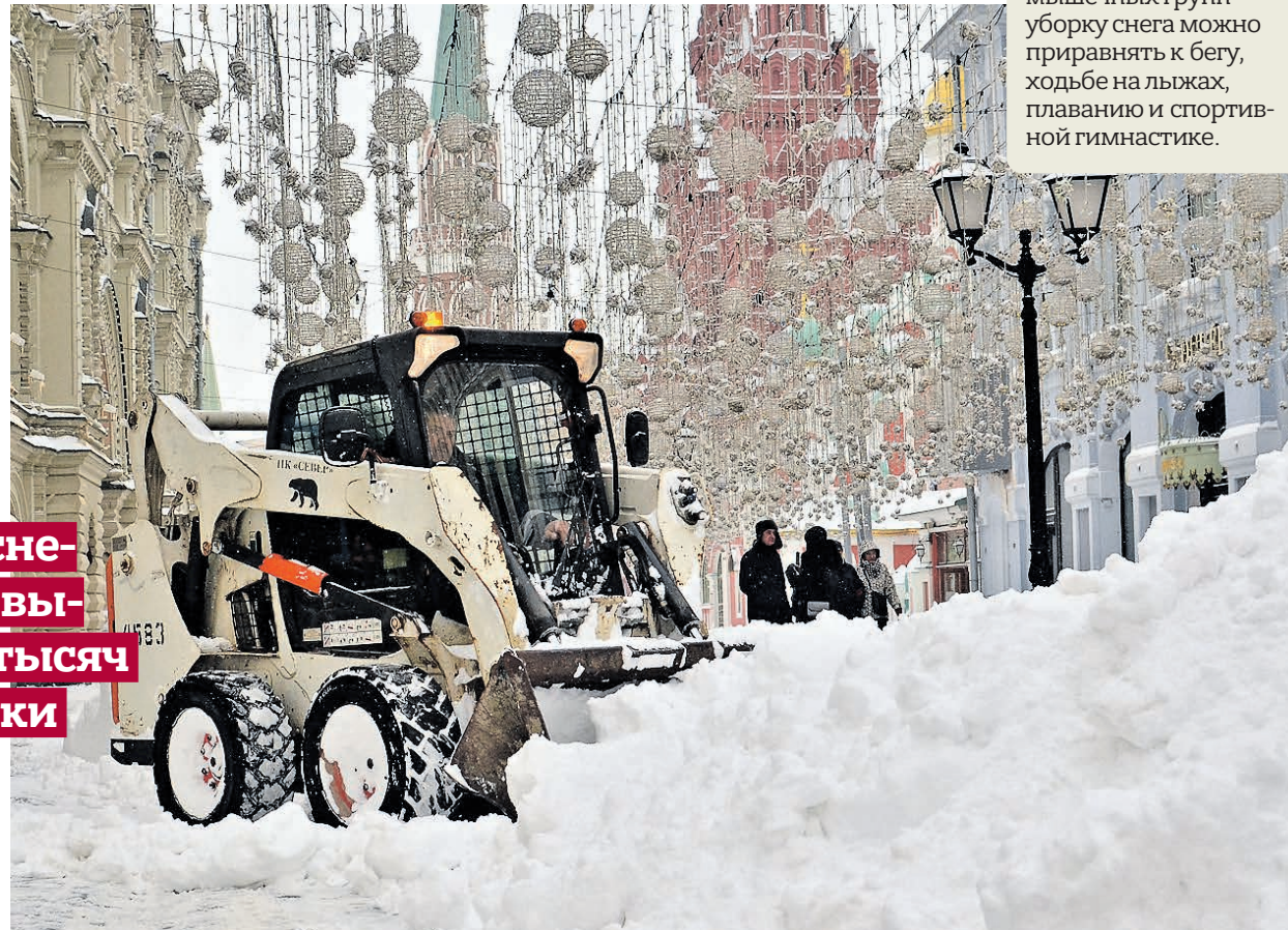
14 февраля 2021 года. Справляться с последствиями обильного снегопада столичные коммунальщики будут еще несколько дней. Работы по расчистке улиц подходят к концу, и теперь особое внимание уделяется уборке дворов
